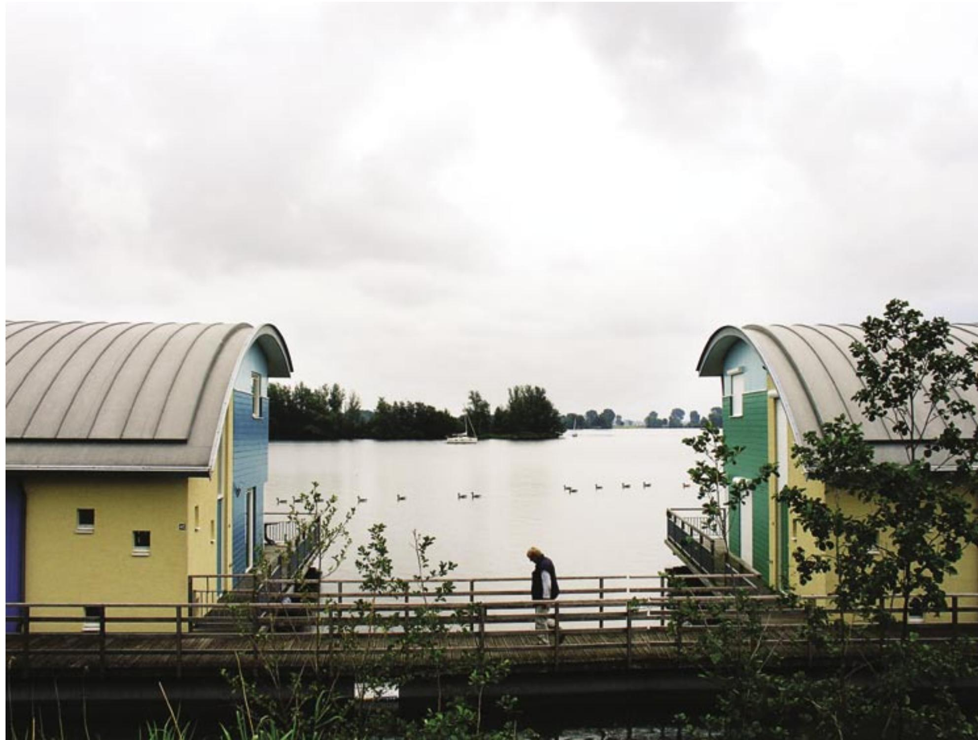
Sala, cozinha, três dormitórios. E bóiam na água. Nas margens dos rios ao sul da Holanda, há casas adaptadas a uma variação de 6 a 8 metros do nível do mar. Quando a água desce, ficam sobre bases de concreto. Quando sobe, ficam seguras por estruturas de metal que unem umas às outras. São moradias experimentais, e todas foram vendidas
